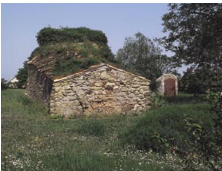
Vue postérieure d'un four couché. Le massif de la chambre de cuisson est couvert en tuiles creuses. La fosse d'accès au foyer a été comblée, mais sa gueule, murée, est encore visible. Les Rairies, les Buttes.
