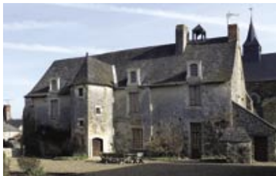
Logis du prieur : façade sud avec la tour d'escalier.
