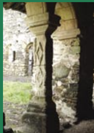
Arcade du cloître : pilier avec décor de losange.
